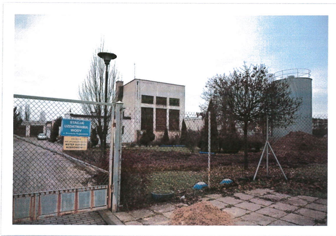
Stacja Uzdatniania Wody w Brześciu Kujawskim
