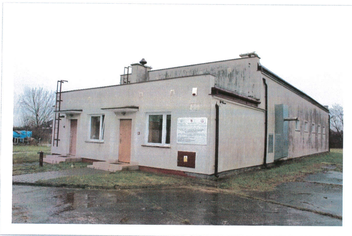
Stacja Uzdatniania Wody w Brzeziu
