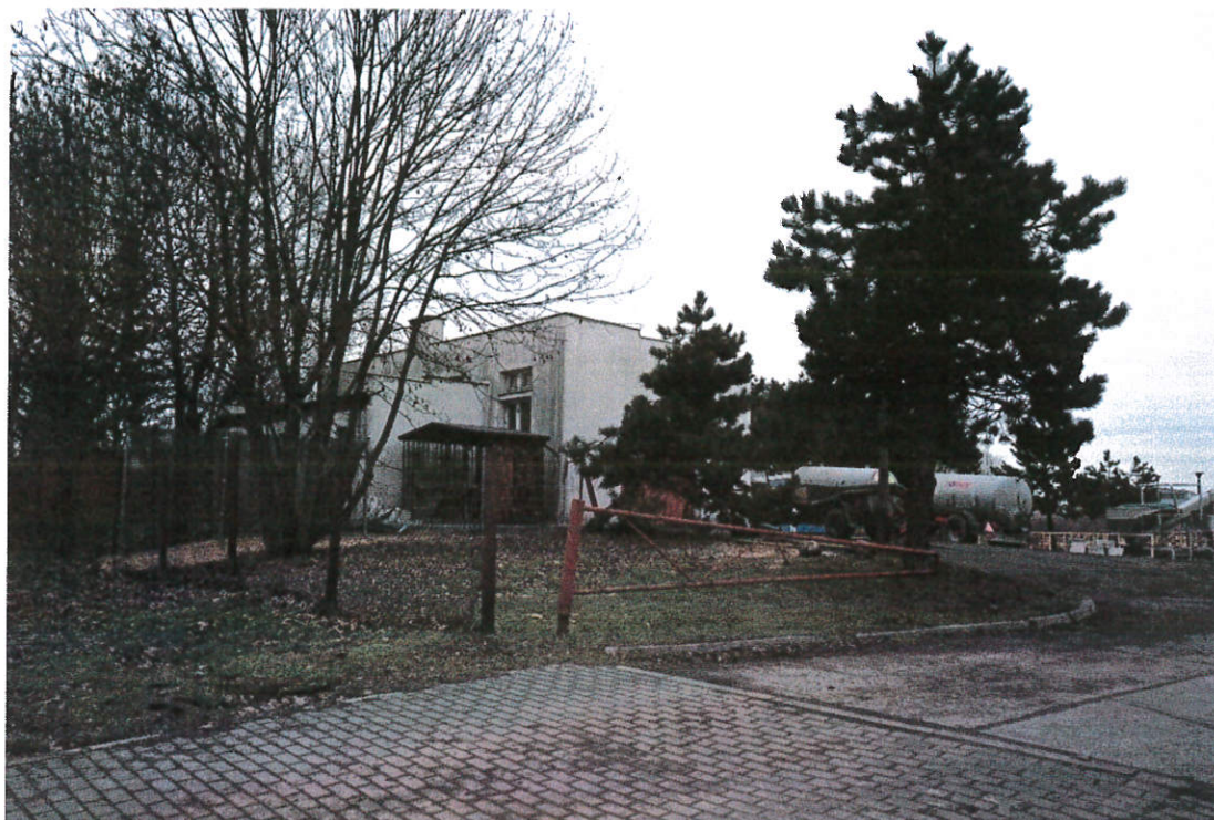
Oczyszczalnia Ścieków w Starym Brześciu
