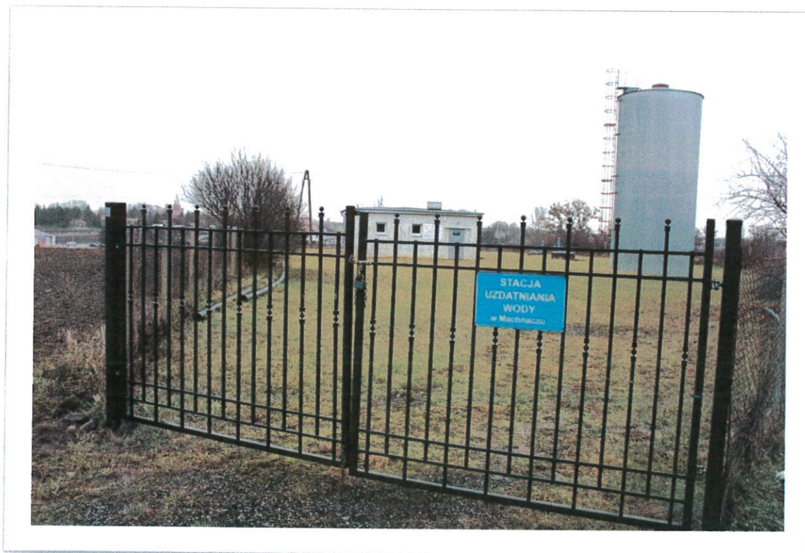
Stacja Uzdatniania Wody w Machnacu
