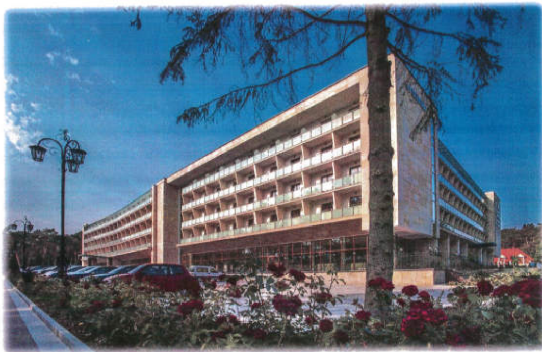
Zdjęcie 1. Widok na główny budynek Uzdrowiska w Wieniecu Zdroju. Źródło: https://uzdrowisko-wieniec.pl/galeria/?lg=1&slide=1
